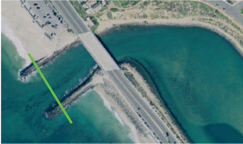
Agua Hedionda Lagoon - Existing Channel
