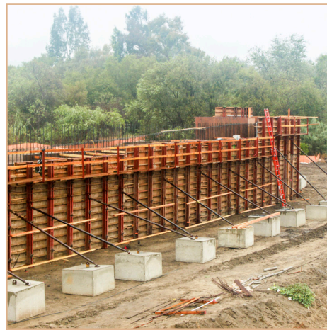
Construcción en la parte oeste de la base del puente.
