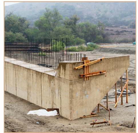
Construcción de la base del puente en la parte este.
