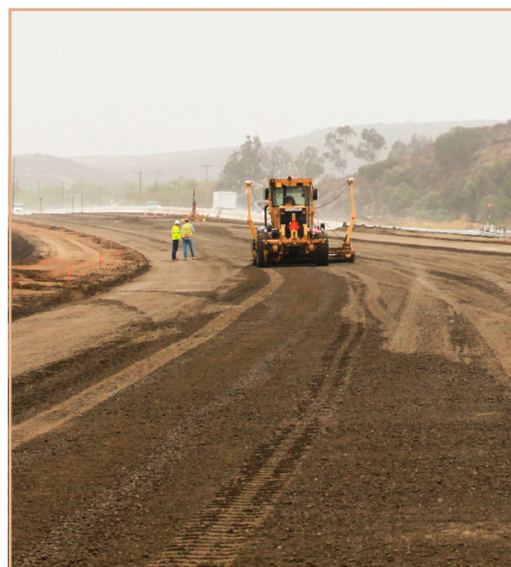
Equipos de construcción preparan la pavimentación de los carriles nuevos.
