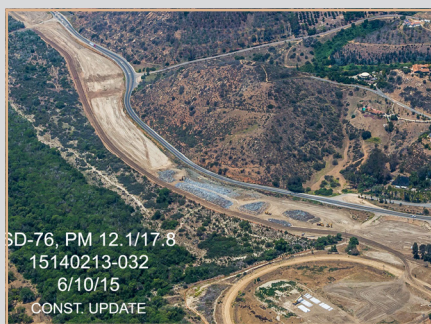
Vista desde el cielo del Segmento Este de SR 76.
