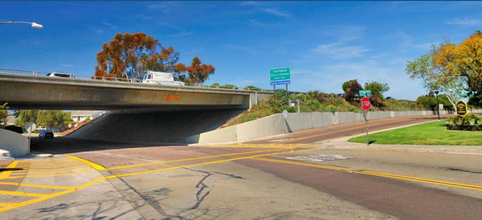
Cruce subterráneo existente en la I-5 en Chestnut Avenue
