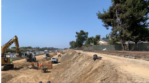
Muro acústico de Altamira I-5 en dirección norte (al norte de Poinsettia Ln.)
