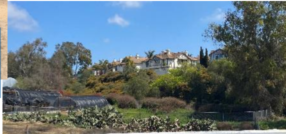
Muro acústico de Saxony I-5 en dirección norte (al norte de Encinitas Blvd)
