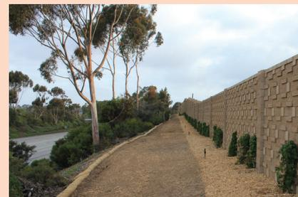
Diseño de un muro acústico típico a lo largo de la I-805. El diseño de los muros acústicos variará dependiendo de su ubicación y puede incluir mampostería, vidrio u otros materiales.
