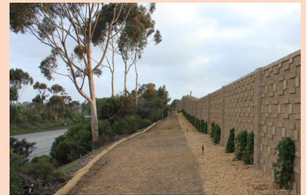
Diseño de un muro acústico típico a lo largo de la I-805. El diseño de los muros acústicos variará dependiendo de su ubicación y puede incluir mampostería, vidrio u otros materiales.
